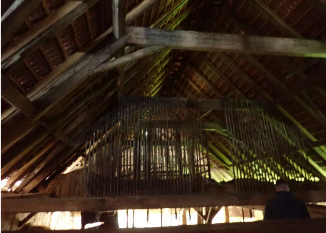
Dachbereich des Wirtschaftsgebäudes Weltestr. 1
