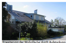
Erweiterung der Wohnfläche durch Aufstockung
