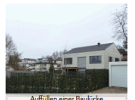
Auffüllen einer Baulücke
