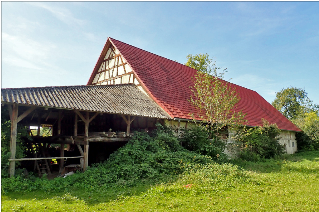
Abbildung 6: Pferdestall; Bruthabitat von Gebäudebrütern wie Rauchschnalbe, Hausrotschnalbe und Bachstelze; im Inneren des Pferdestalls Schleiereulen-Gewölle , aber keine Hinweise auf aktuelle Brut. Bild 20.9.19.
