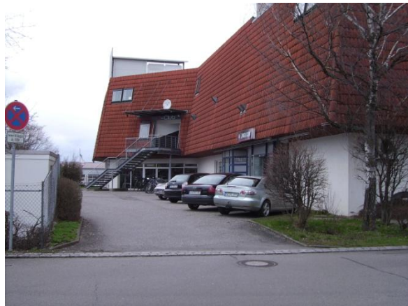
Foto 20: Gesamteindruck des Gebäudes
